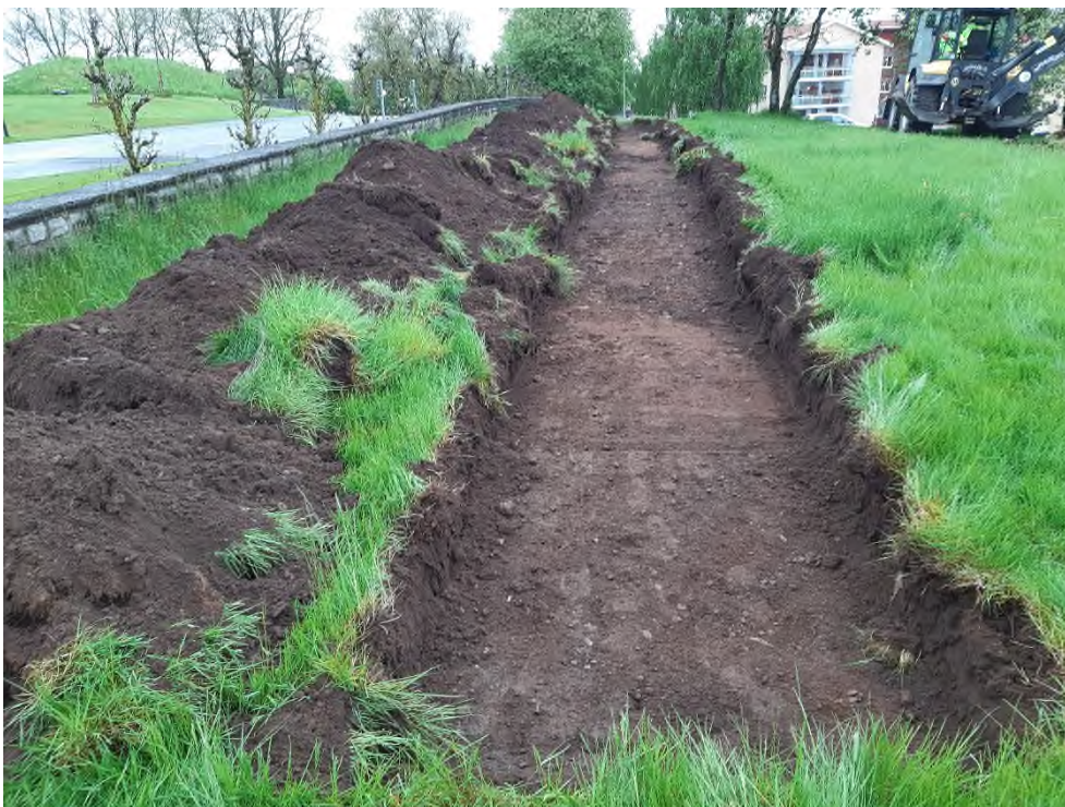
Fig. 3. Översikt schakt 1. Foto från väst.
